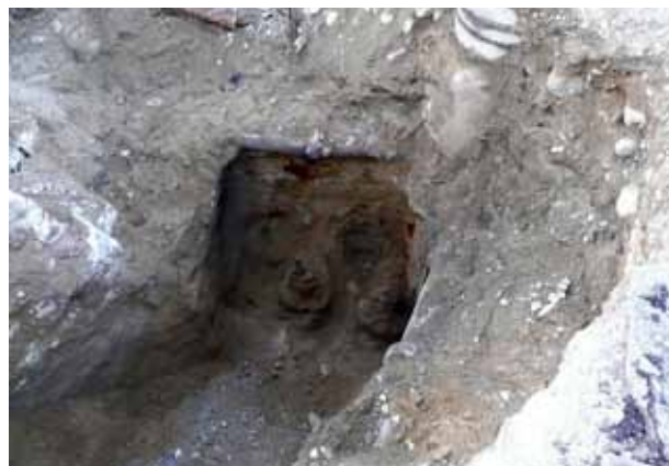
Ibland är det trångt att komma åt ledningarna. Här var det berg på ena sidan och dagvattenledningar på de andra sidorna.
